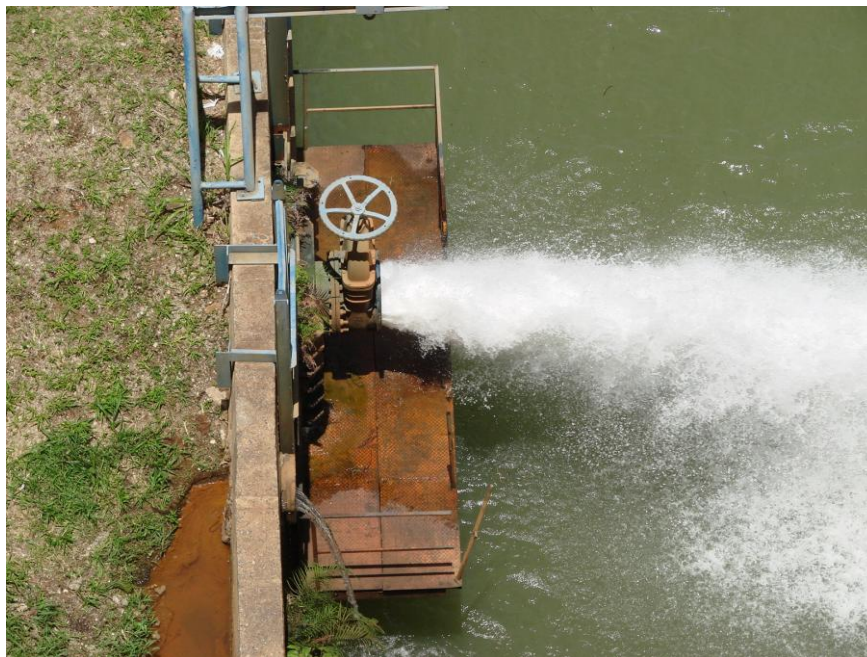
Figura 5.9: Descarga de fundo da barragem do rio Descoberto 3
