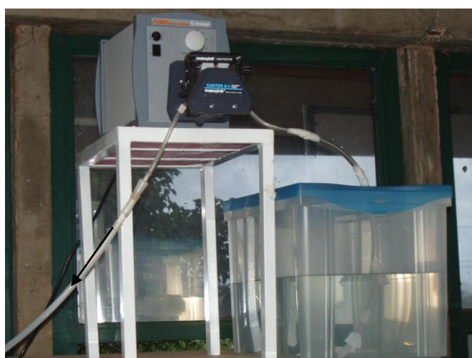
Figura 4.5 – Reservatório de coagulante e bomba dosadora
