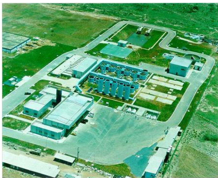
Figura 4.4 - Foto da ETA pípiripau
